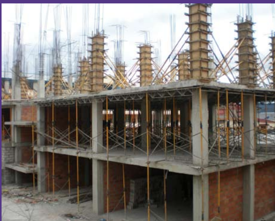
Bau der Universität Politecnica Salesiana
