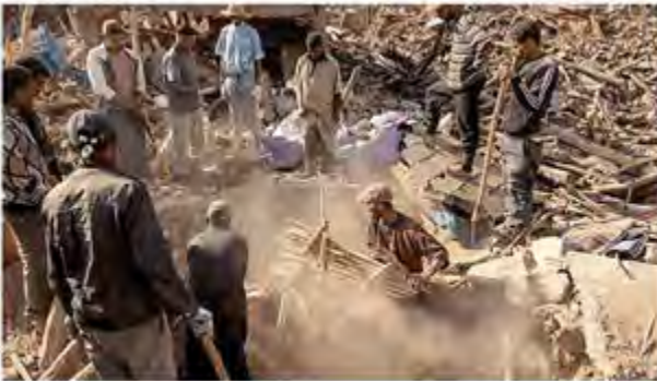
Helfer graben im Schutt eingestürzter Häuser in Dorf bei Anzilmez
