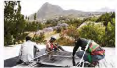
Bei der Installation von Solaranlagen ist lokale Expertise unerlässlich
