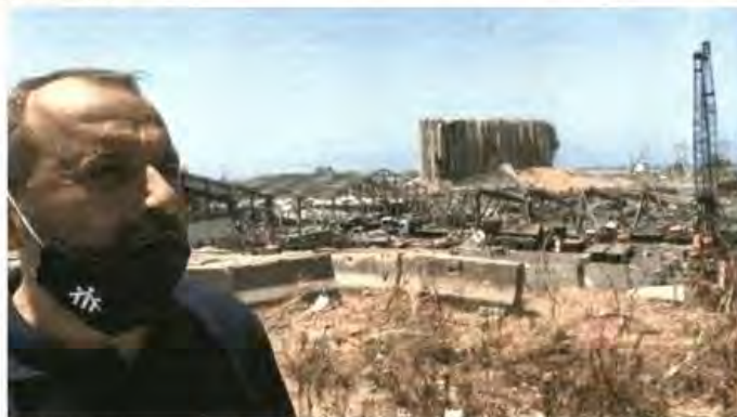
BEIRUT Blick auf den völlig zerstörten Hafen und Wohnviertel links
